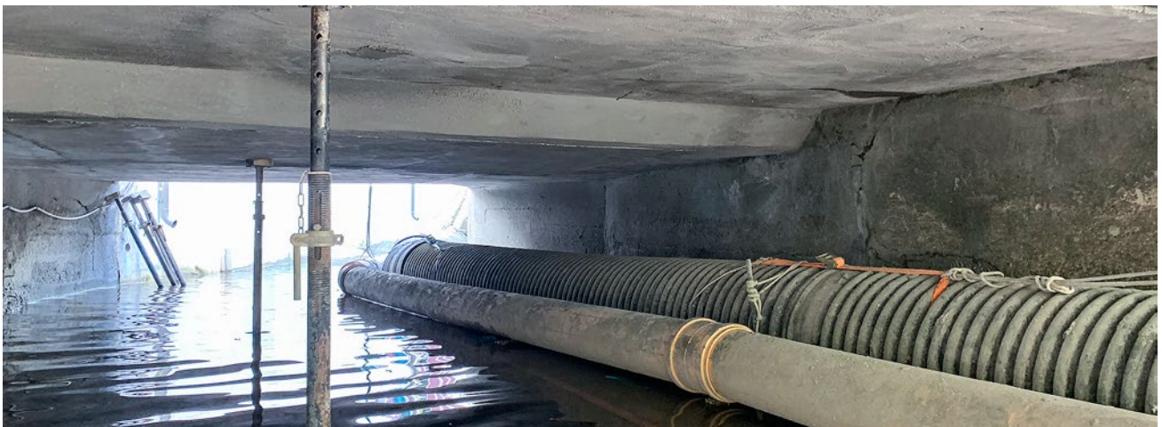
Doorlaatruimte na versterking
