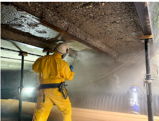
Na verwijderen van de middenwand, provisorisch ondersteunen en hydromechanisch opruwen.
