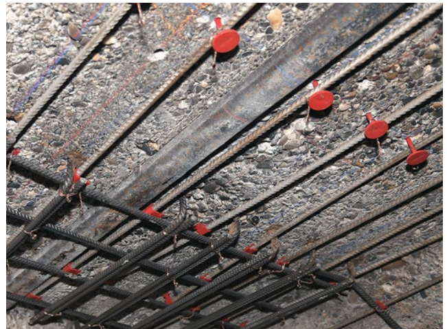
Fixeren van re-bar aan internewapening (re-clip) en aan dragende ondergrond (re-bolt)
