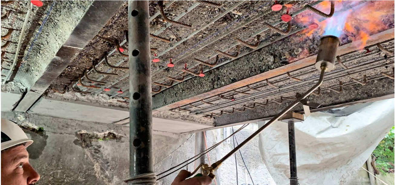
Aktivering van re-bar met gasvlam en temperatuurcontrole
