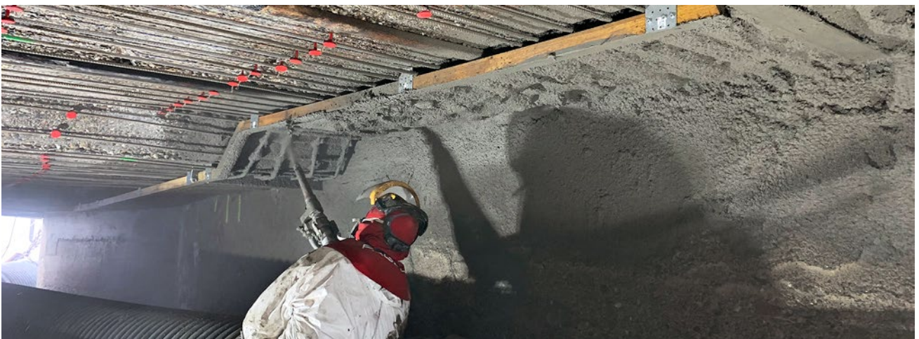
Tweezijdige eindverankering van de 600 mm re-bar staven met Sika MonoTop® nattespuitmortel
