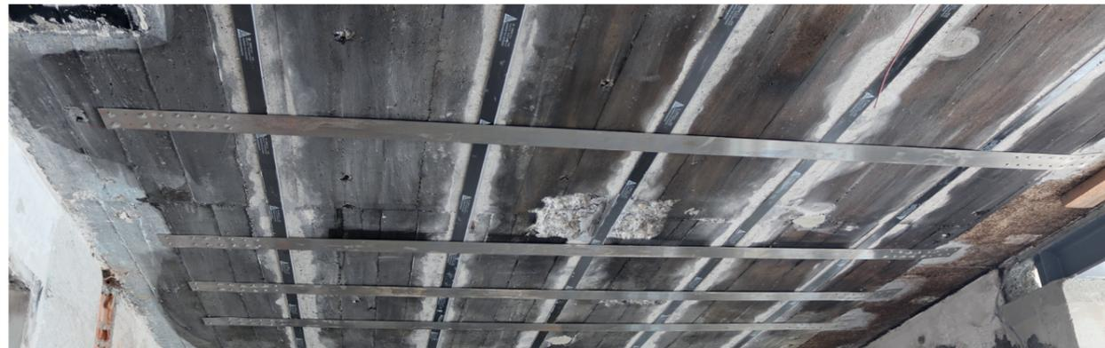
1. Kombination von re-plate und Sika® CarboDur® zur Biegeverstärkung
