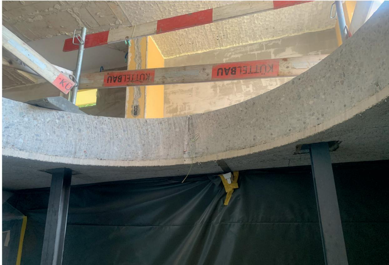
1. Einbau von zusätzlichen Stahlstützen infolge einer neuen Aussparung
