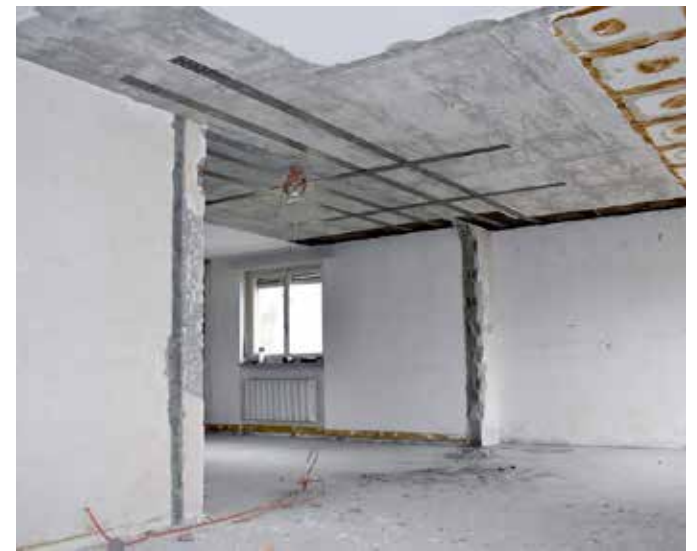
7 re-plate volledig aangebracht en voorgespannen - dragende ondersteuning kunnen nu worden verwijderd - indien nodig, systeem-geteste Sika brandwerendheidssysteem aanbrengen of brandwerende beplating
