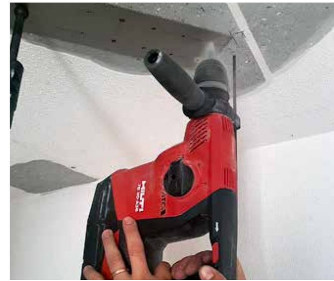
3 Ondergrond voorboren door voorgeperforeerde re-plate, boordiameter Ø 3,5 mm
