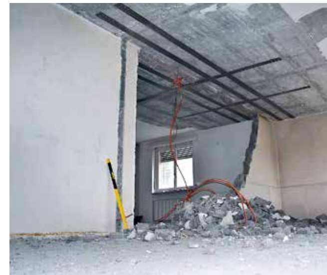
7 re-plate volledig aangebracht en voorgespannen - dragende ondersteuning kunnen nu worden verwijderd - indien nodig, systeem-geteste Sika brandwerendheidssysteem aanbrengen of brandwerende beplating
