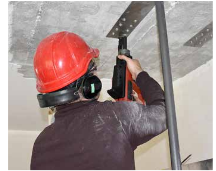
4 Mechanische eindverankering met Hilti gereedschap en systeemgeteste, roestvrijstalen nagel (X-CR 48 P8 S15)
