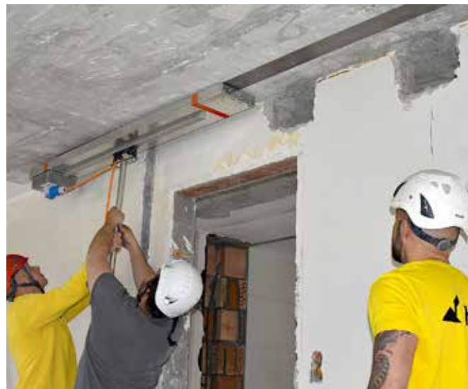
5 Stapsgewijze verwarming met re-IR 3000 infraroodverwarming
