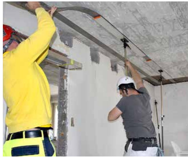
2 Bevestig de re-plate tijdelijk met T-steunen
