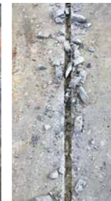
1 Het inbrengen van de groef in de betonnen ondergrond (breedte 3,5 cm / diepte 2,5 cm / voor re-bar Ø12 mm)
