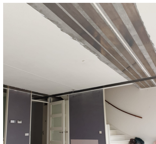
zowel de CFRP als de re-plate lamellen gereed
