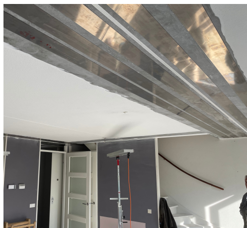
10 Geactiveerde re-plate lamellen voorgespannen
