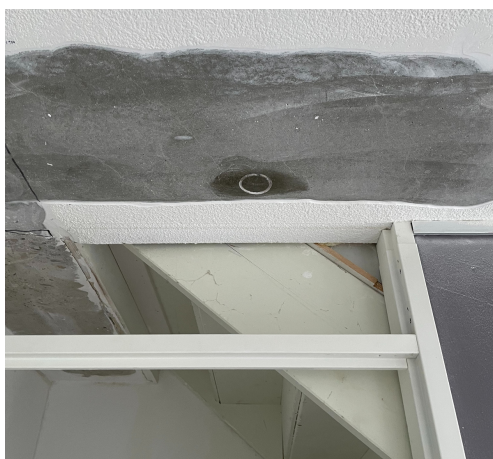
Hecht sterkte locatie waar CFRP wordt verlijmd
