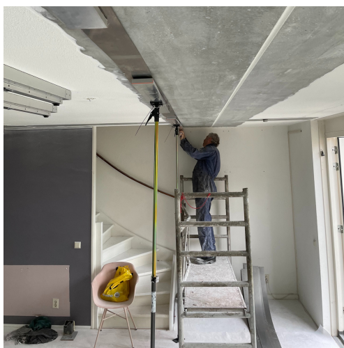
Plaatsen 1e re-plate memory steel lamel
