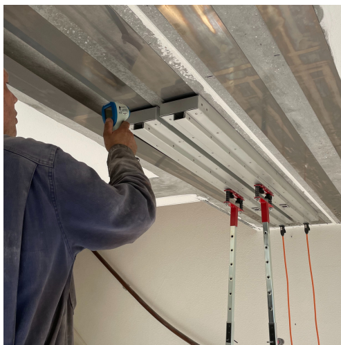
Activeren van re-plate met Infrarood Heater
