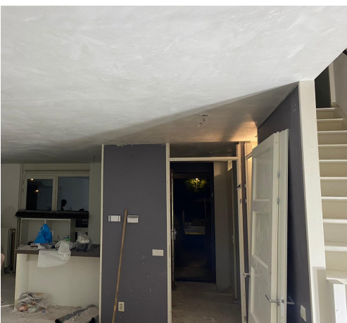
Plafond voorzien van een gipslaag en afgewerkt
