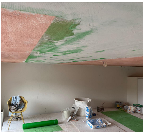
Plafond geprimed, locatie re-plate voorzien van een 1e laag gips waarin een gaas is verwerkt
