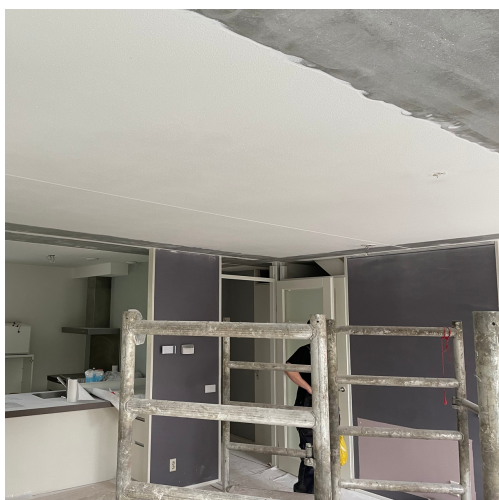
Oude situatie waar voorbehandeling ondergrond plafond is uitgevoerd
