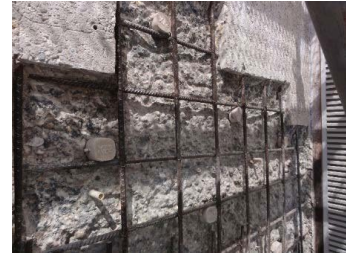
Figuur 1: Kathodische bescherming van gewapend beton d.m.v. opofferanodes
