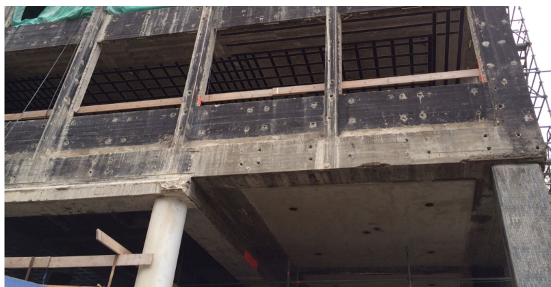
Versterking verdiepingsvloer met koolstoflamel IG CFK150/2000
