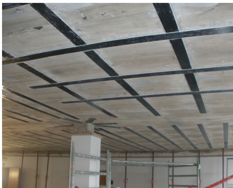
*foto klant aangebrachte IG CFK 150/2000 onderzijde vloer Utiliteits gebouw
