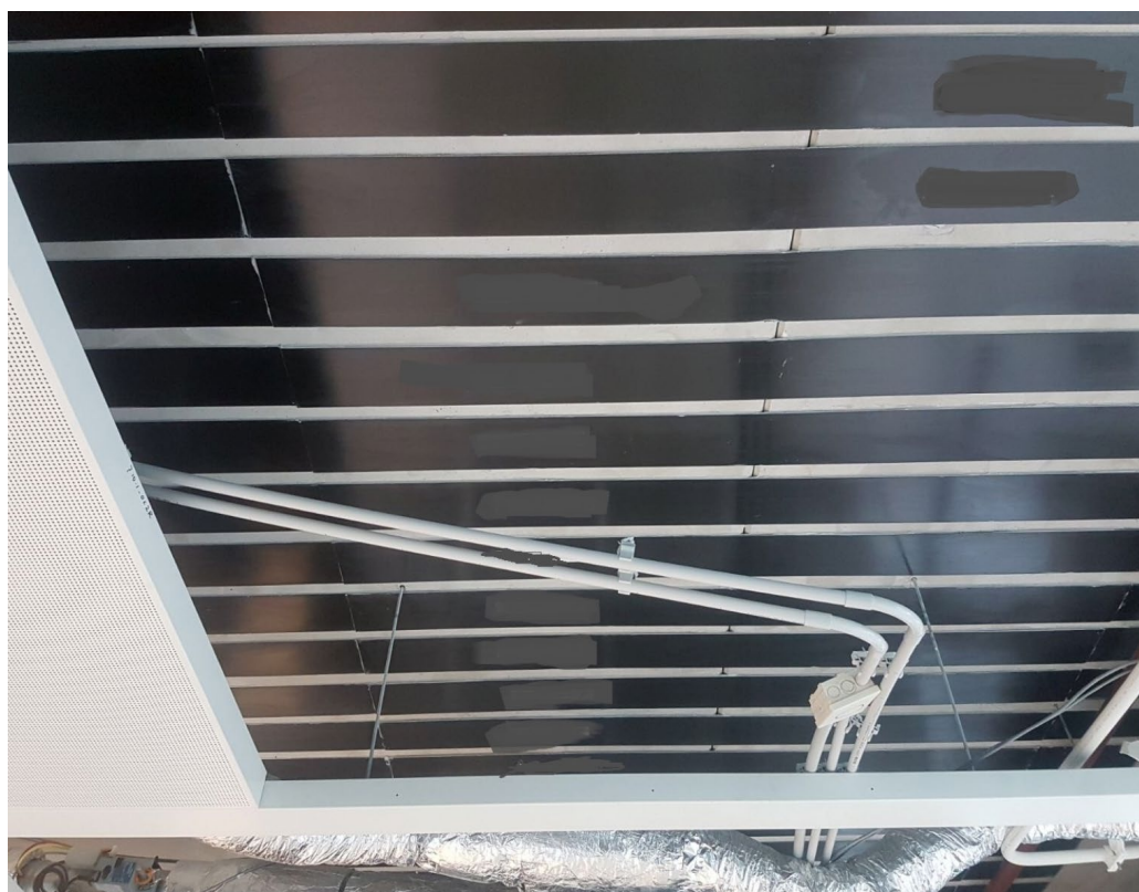
*foto klant aangebrachte lamellen IG CFK150/2000 onderzijde bollenplaatvloer/Breedplaatvloer
