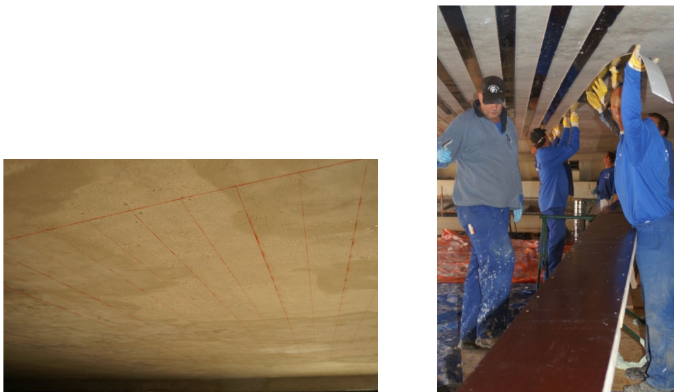
Uitzet werk tbv het aanbrengen van Koolstoflamellen Aanbrengen van een Koolstoflamel in teamverband
