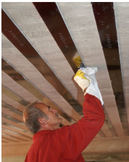
Reinigen van de aangebrachte Koolstoflamel
