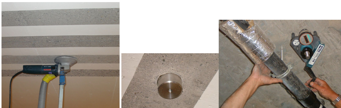
Reinigen/schuren ondergrond Hechtsterkte meting op de beton ondergrond + treksterkte meter
