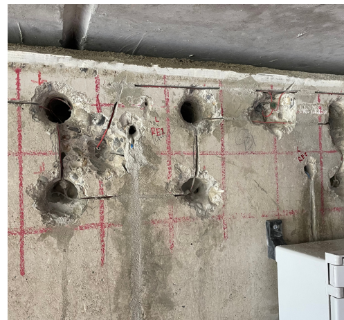
Ligger waar anodes zijn aangebracht en verbonden
