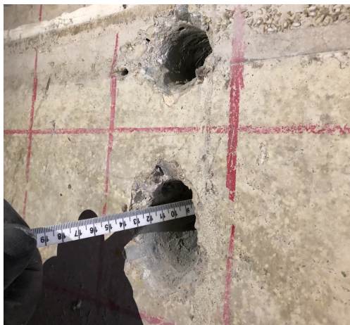
Controle diepte boorgat t.b.v. anode
