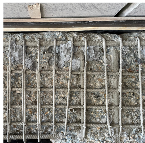
Ligger waar anodes zijn verlijmd in geboorde gaten
