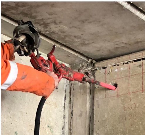
Boren van gaten in de ligger
