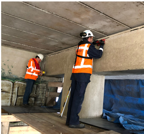
Scannen wapening in ligger waar geboord kan worden
