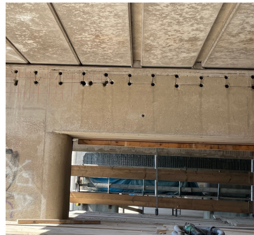
Gatenpatroon in ligger t.b.v. opofferanodes
