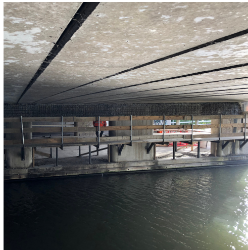
Boren van gaten in de ligger
