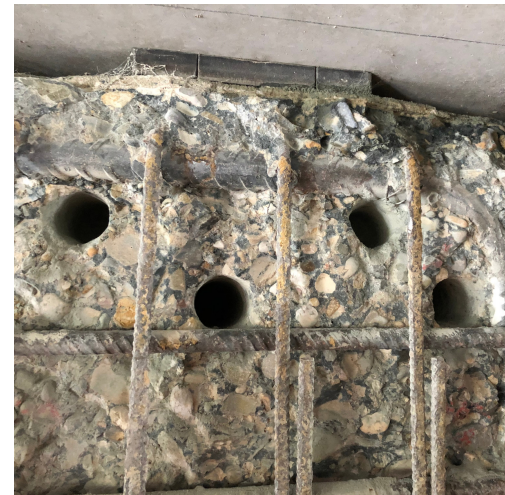
Close-up gatenpatroon t.b.v. anodes betonligger
