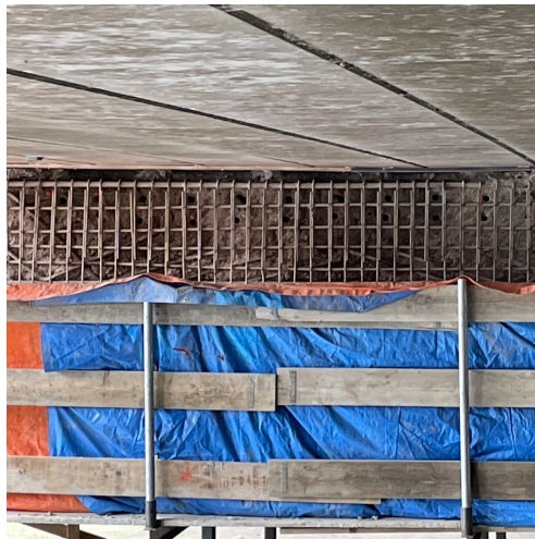
Scannen wapening in ligger waar geboord kan worden
