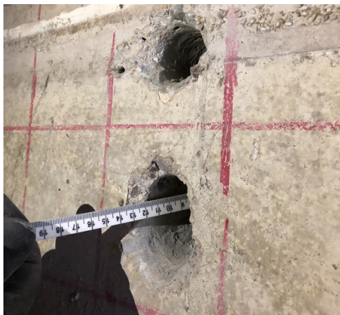
Controle diepte boorgat t.b.v. anode
