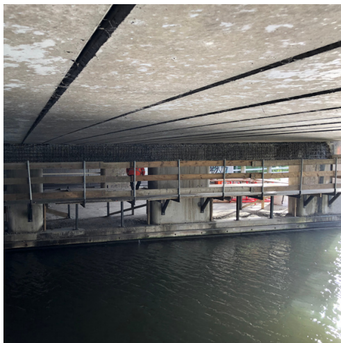
Boren van gaten in de ligger
