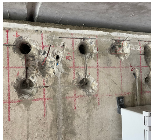
Ligger waar anodes zijn aangebracht en verbonden
