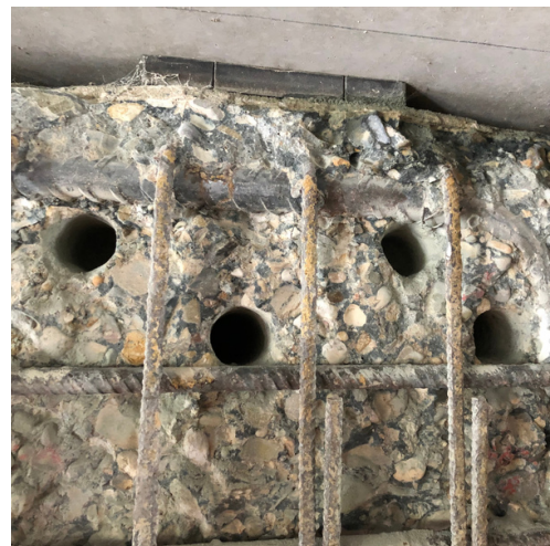
Close-up gatenpatroon t.b.v. anodes betonligger
