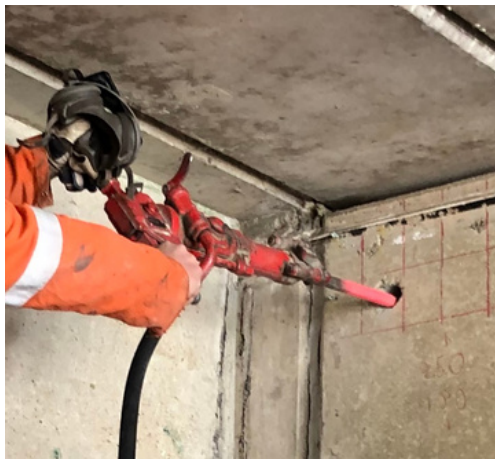
Boren van gaten in de ligger
