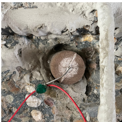
Close-up aansluiten geplaatste opofferanode
