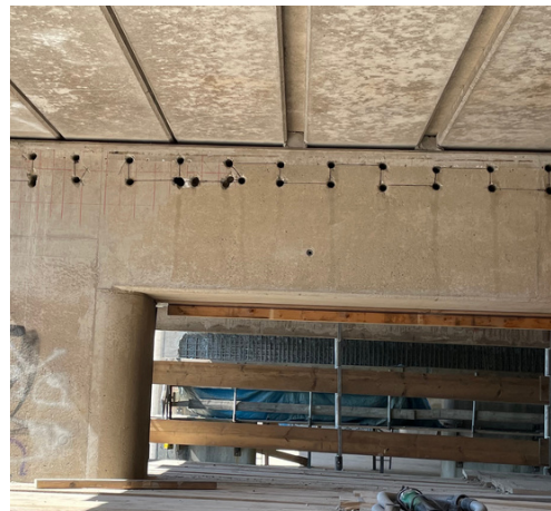
Gatenpatroon in ligger t.b.v. opofferanodes
