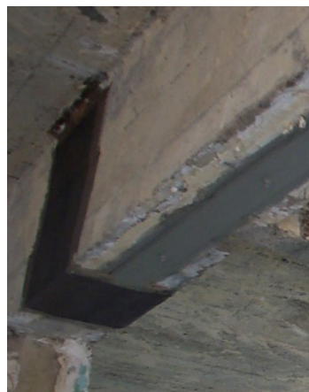
Figuur 4: Toepassen van extra verankering d.m.v. gelijmde wapening (C-Sheet UD) dwars op de gelijmde hoofdwapening
